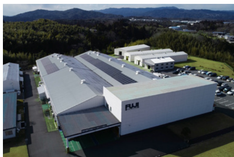
太陽光パネル (関西電力資産)
