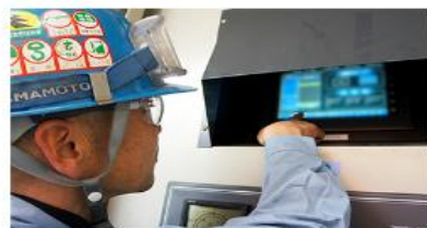
自家発電機の自動制御システムによる緻密な調整で、需給調整の要請に応える
