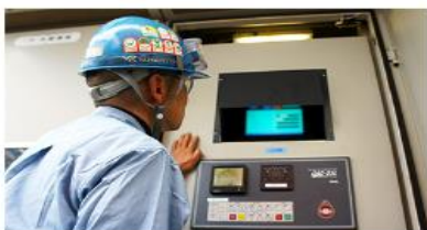
自家発電機の自動制御システムによる緻密な調整で、需給調整の要請に応える
