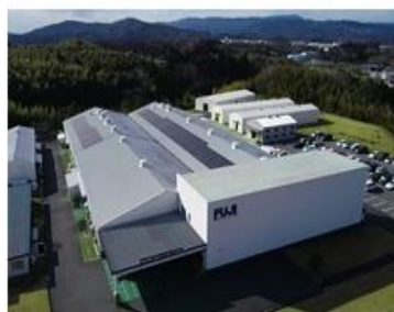
太陽光パネル (関西電力資産)
