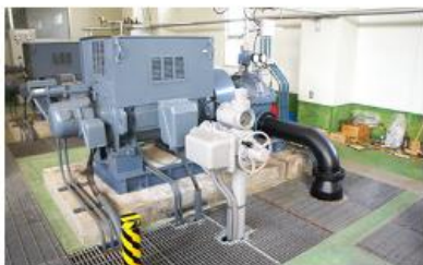
平浄水場に設置された送水ポンプ。隣接する富田川の地下水から取水・浄水後、2ヵ所の配水池へ送水する
