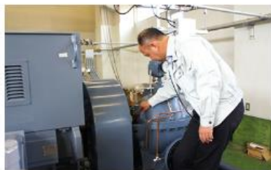
平浄水場に設置された送水ポンプ。隣接する富田川の地下水から取水・浄水後、2ヵ所の配水池へ送水する
