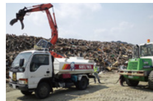
被災現場の復興用重機への軽油燃料配送
